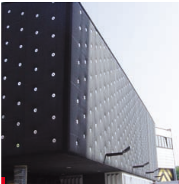
Resitrix na elewacji – mocowany mechanicznie łącznikami
