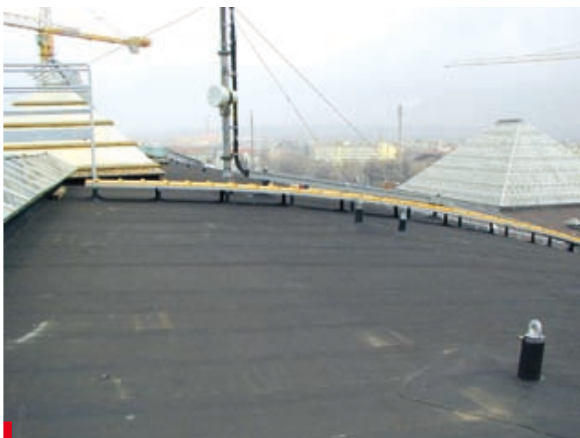
Resitrix w postaci „klasycznej”, czyli zgrzewany na dachu
