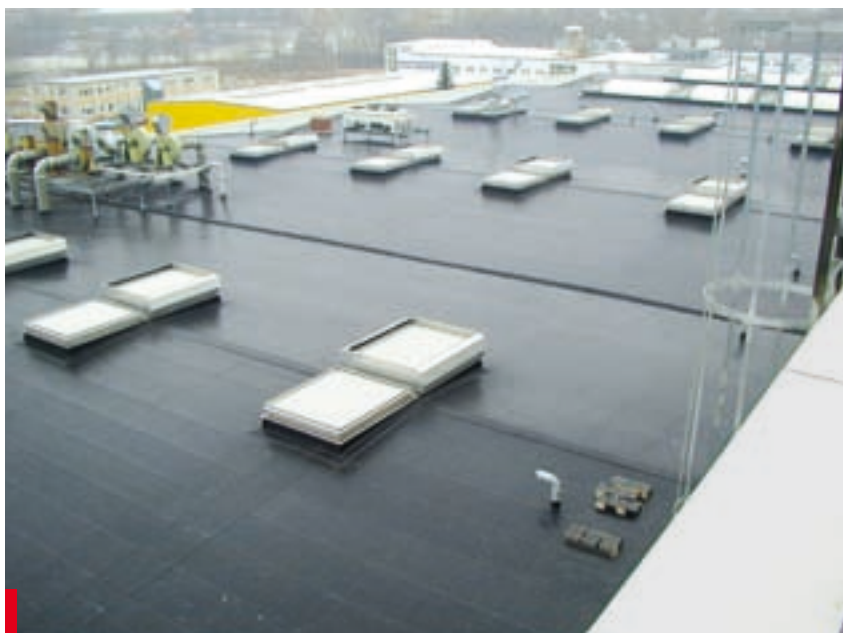
Membranę z EPDM bez problemu można obrobić wszelkie elementy wystające ponad dach
