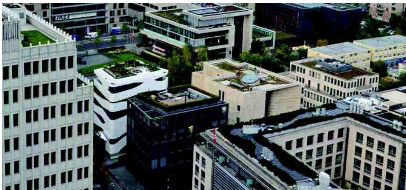
Widok na dachy zielone przy placu Poczdamskim w Berlinie Źródło: APK Dachy Zielone
