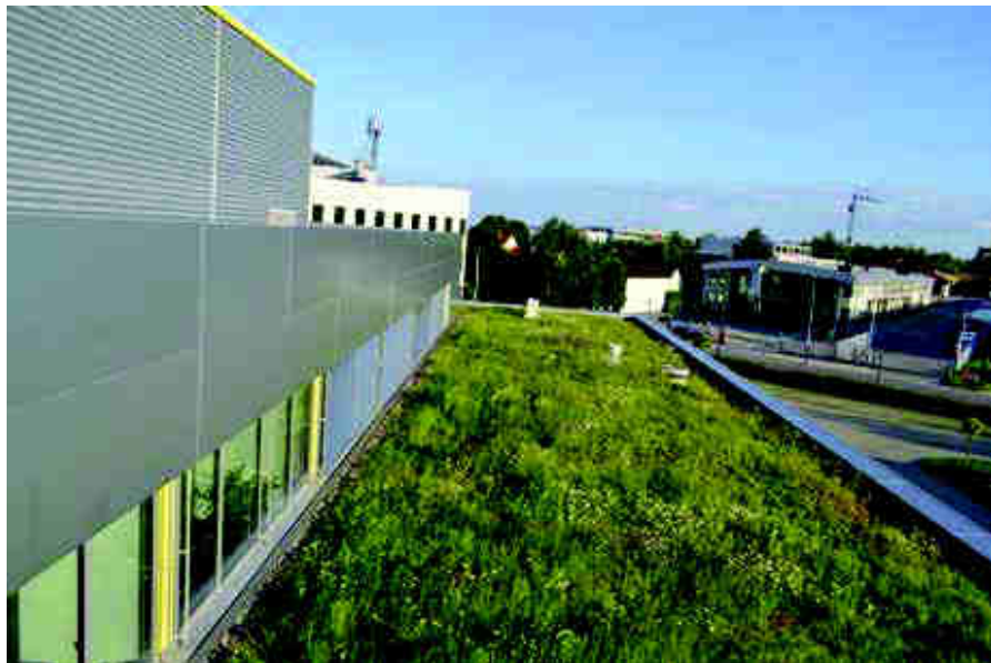
Budynek biurowy w Krakowie, gdzie na trzech dachach zielonych znajduje się łąka kwietna o łącznej powierzchni 800 m 2 . Źródło: APK Dachy Zielone
