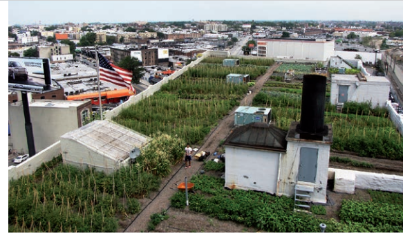
FOT. 1. Przykład farmy miejskiej na zielonym dachu, fot.: Optigruen
