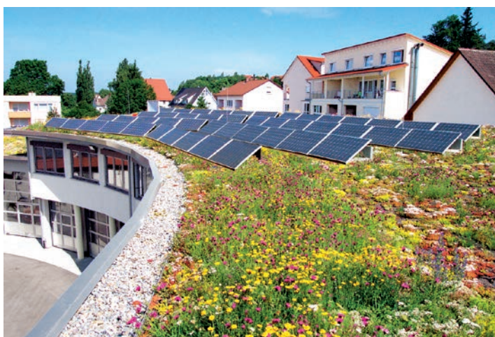
■ Fot. 1. Połączenie dachu zielonego z panelami fotowoltaicznymi podnosi efektywność instalacji solarnej
