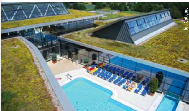
Fot. 2. Dach ekstensywny o powierzchni 3400 m 2 na parku wodnym w Filderstadt (Niemcy)
