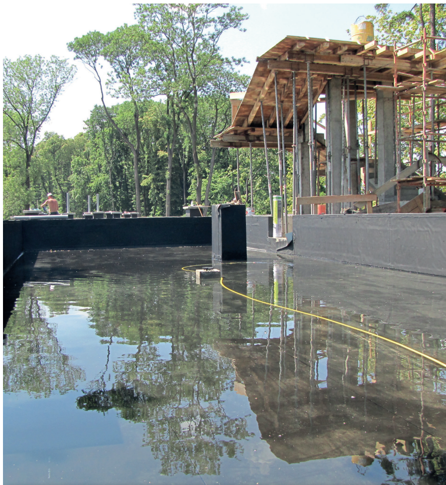
Próba szczelności wodnej przed ułożeniem pozostałych warstw dachu zielonego
