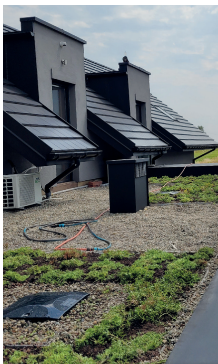
Taras zielony wykonany z sadzonek rozchodników. Wpust z nadstawką rewizyjną. Wokół wpustu i na brzegach zastosowano opaski zabezpieczające
