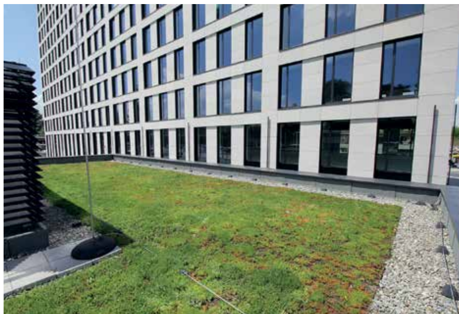
Opaski żwirowe na dachu w uprawie ekstensywnej
