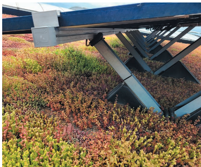
FOT. 2. Rozchodniki na dachu biosolarnym; fot.: Piotr Wolański, APK Dachy Zielone
